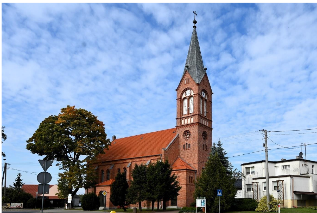
Kościół pw. św. Andrzeja Boboli w Sicienku – neogotycka, ceglana świątynia wzniesiona w 1887 r. jako kościół ewangelicki, z wieżą ukończoną w latach 1892–1893. Budowla,
